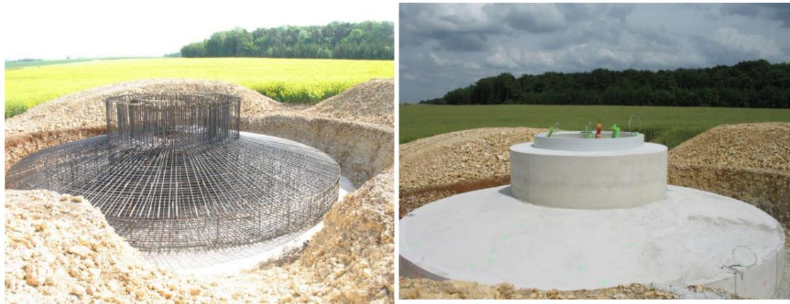
Photo 10 Ferrailage d'une fondation et ancrage des mâts
