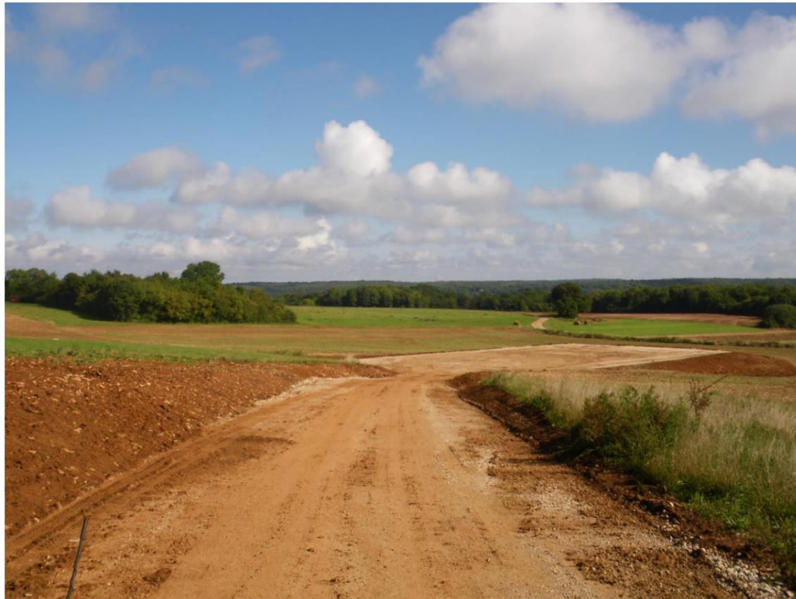
Photo 9 Décapage pour réalisation d'un chemin d'accès et d'une aire de levage
