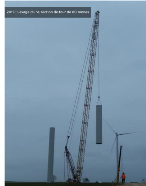
Photo 11 Montage d'une section de mât
