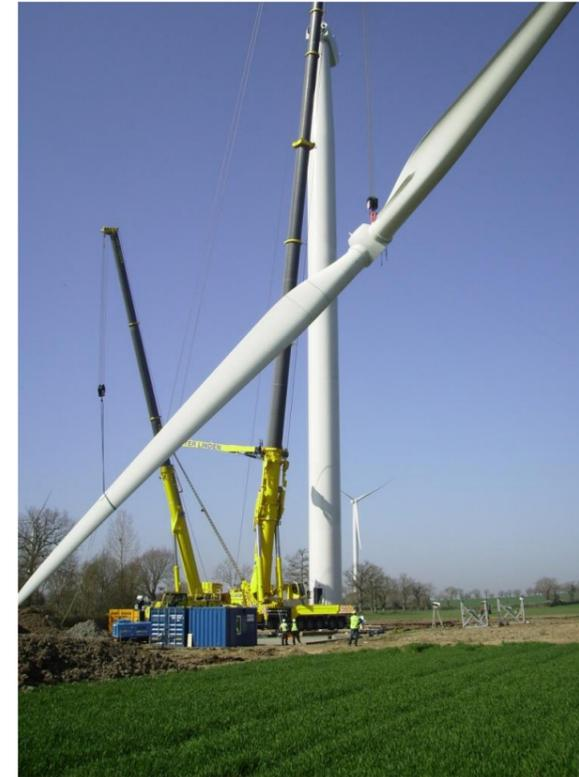
**Photo 14 Montage du rotor et des pales**
